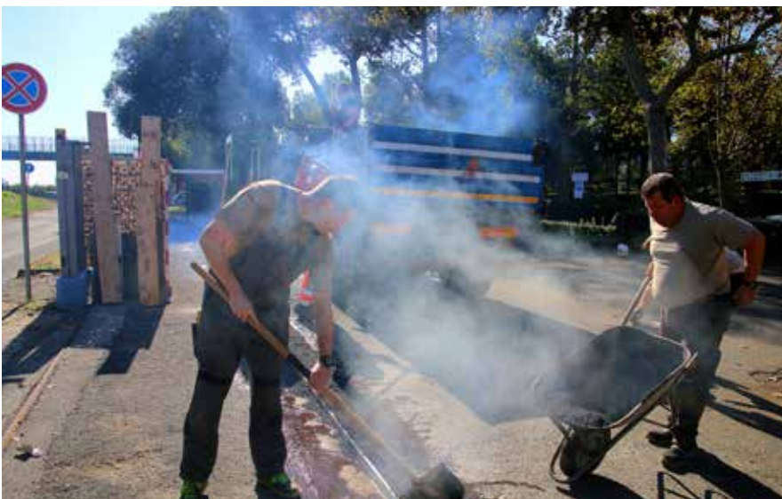
Nachdem der Arbeitstrupp der RK Aalen das Einfahrtstor zum deutschen Soldatenfriedhof Pomezia versetzt haben, versehen Florian und Timo Klöpfer den massiven Unterbau mit einer Asphaltdecke
